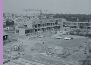
Vue générale sur le chantier de construction Fresnellierie-Ronceray en 1961.
