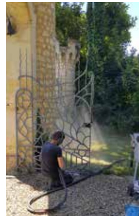
3. Décapage de grille © Aer'hope72
